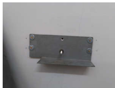
شکل 53- صفحه نصب شده روی دیوار
